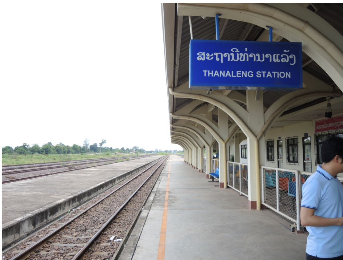
図7-2 VLP 建設予定地に隣接するビエンチャン・タナレン駅
