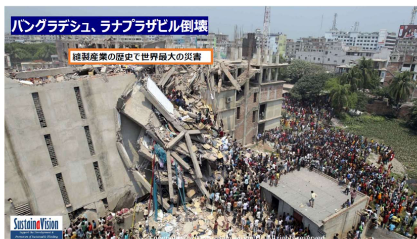
図 53 バングラデシュ、ラナプラザビル倒壊
